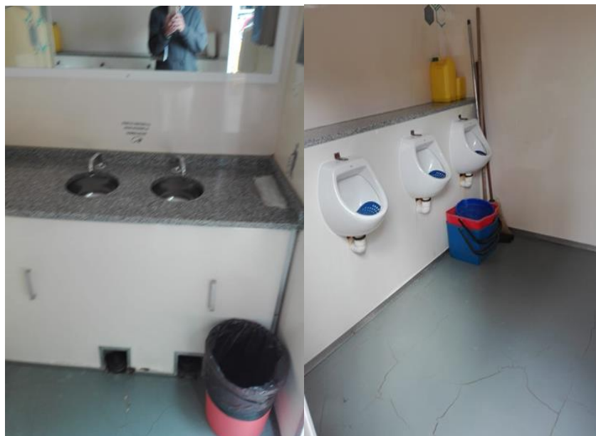
Sector interno del baño para el personal de la UFU
