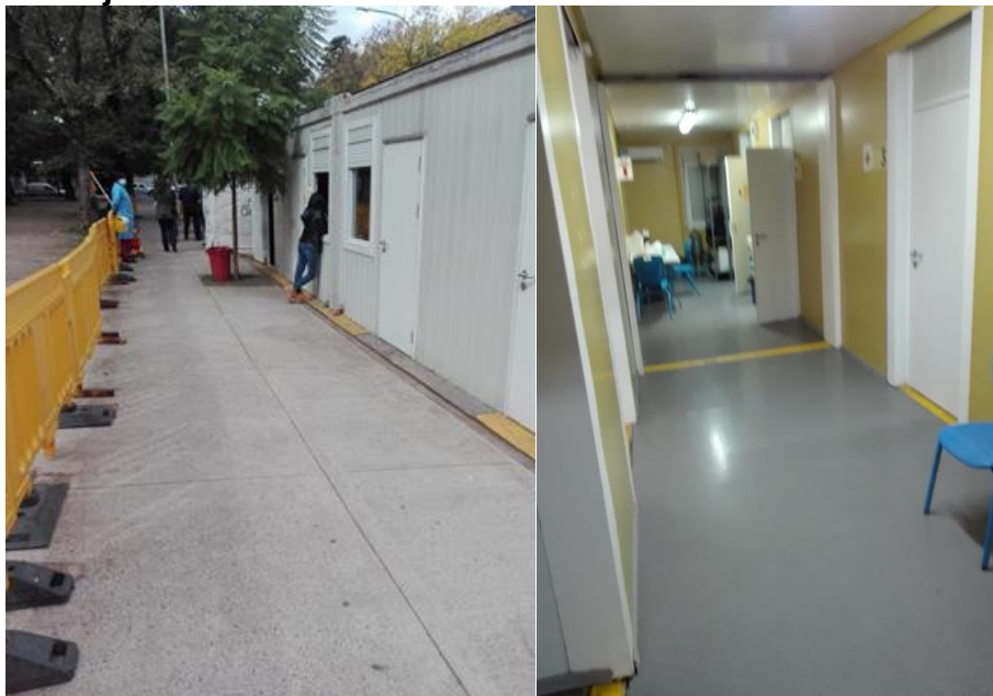
Sector externo de la UFU, sector administrativo. Pasillo de circulación técnico interno de la UFU
