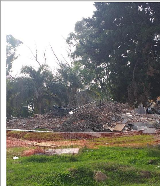
**Foto N° 21 Sitio de carga demolición. Mezcla de Hierros con Escombros.**
