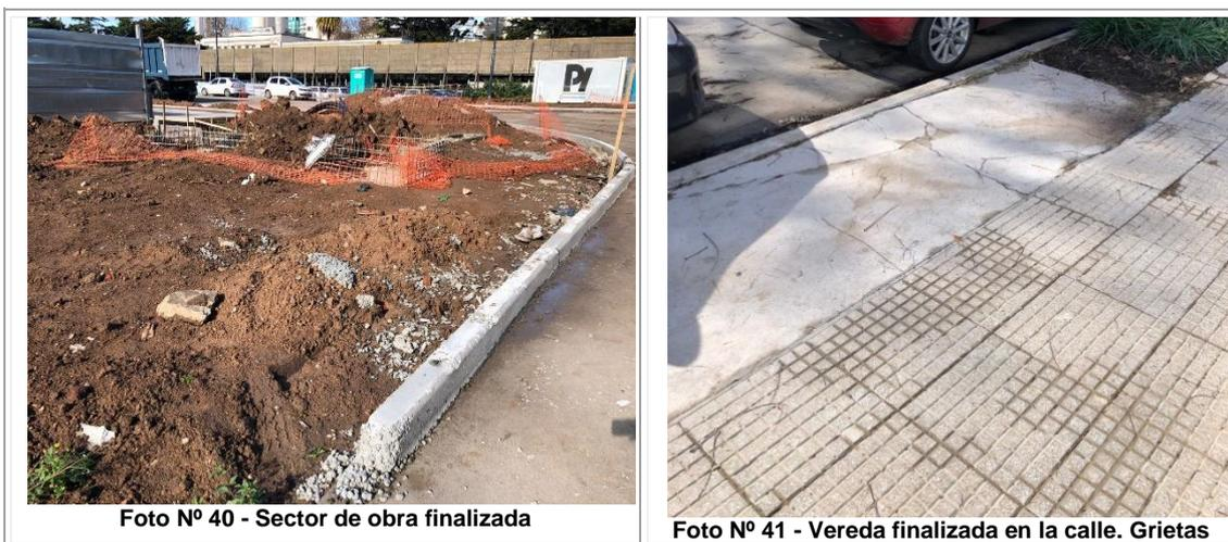
Fotos 40 y 41. Se observan detalles en las obras finalizadas como cordón de vereda sin finalizar, veredas finalizadas con grietas en las zonas hormigonadas.
