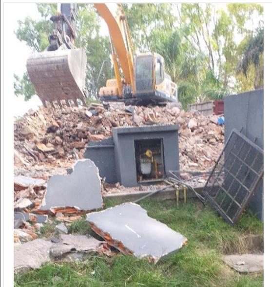
**Foto N° 23 - Sin retiro de medidor de gas**
