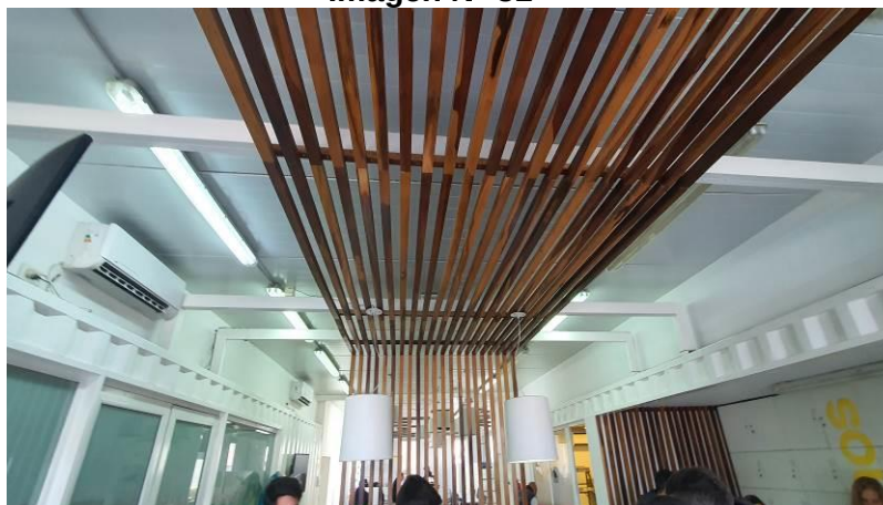
Acceso a la oficina, a la derecha lockers oficina cerrada y baño a la izq. S.R. y baños
