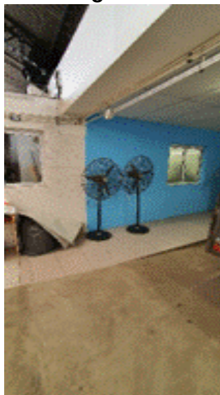
Oficina destinada a la UPE
