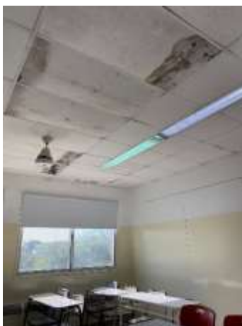
Aulas del 1° piso donde filtra agua. Paneles desmontables sueltos.
