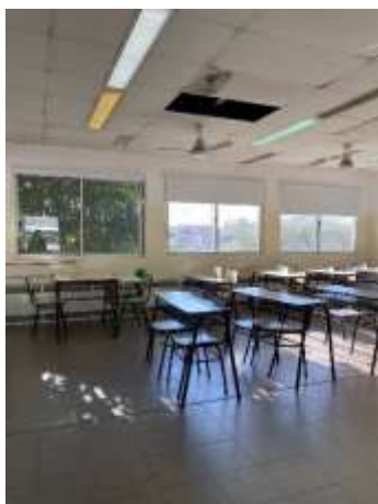
Aulas del 1° piso donde filtra agua. Paneles desmontables sueltos.
