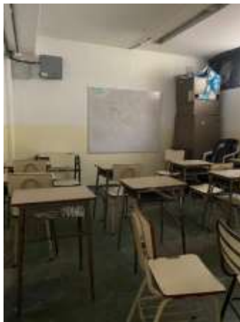
Aulas de dimensiones reducidas, con escasa iluminación y ventilación natural
