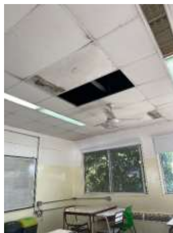
Aulas del 1° piso donde filtra agua. Paneles desmontables sueltos.
