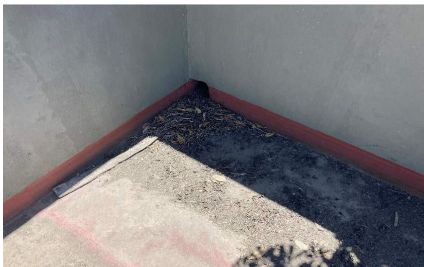
Foto 23: Observación 17: Terraza realizada con un precario sistema de libre escurrimiento.
