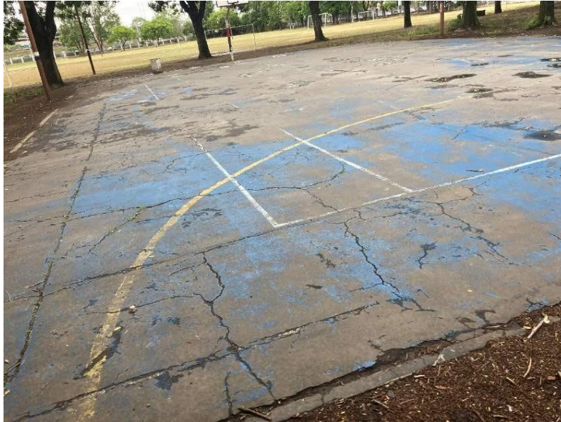
Foto 62: Observación 17: Obra en elaboración: playón deportivo
