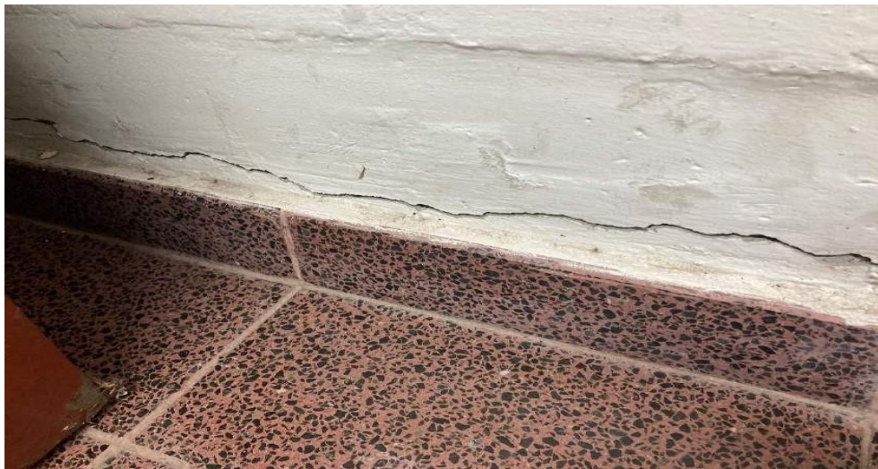
Fotos 28, 29 y 30: Observación 17: Muro medianero con riesgo de caída
