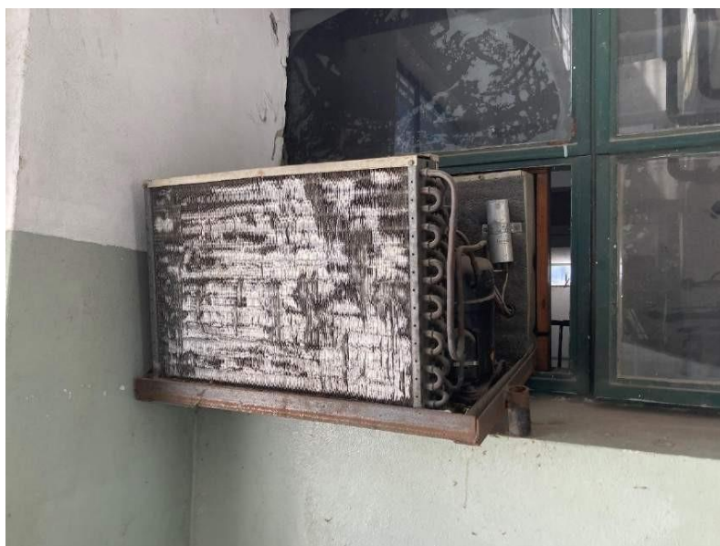
Foto 44.2: Observación 17: Equipo de aire acondicionado sin carcasa
