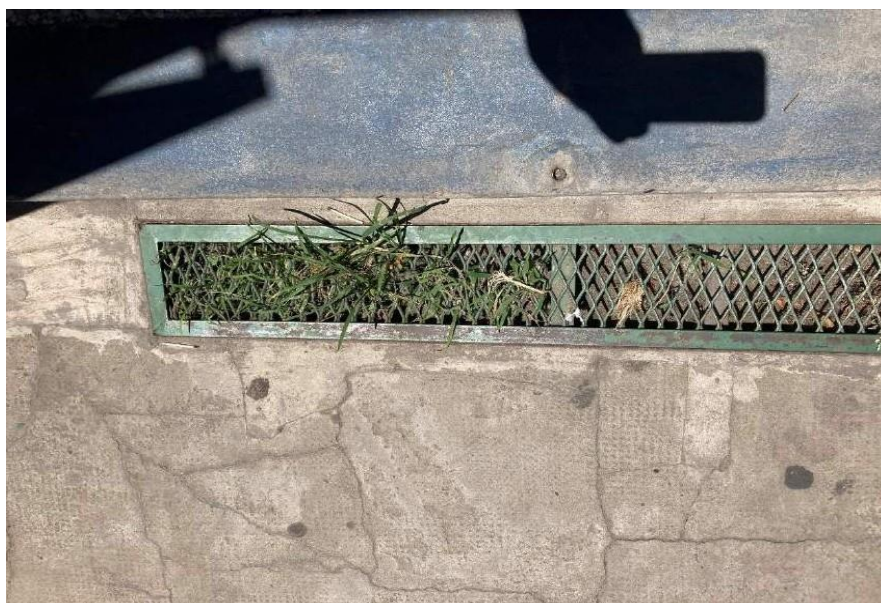
Foto 23: Observación 17: Terraza realizada con un precario sistema de libre escurrimiento.
