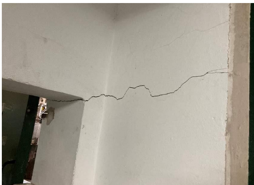
Foto 44: Observación 17: Fisuras horizontales y a 45°, debe verificarse riesgo estructural
