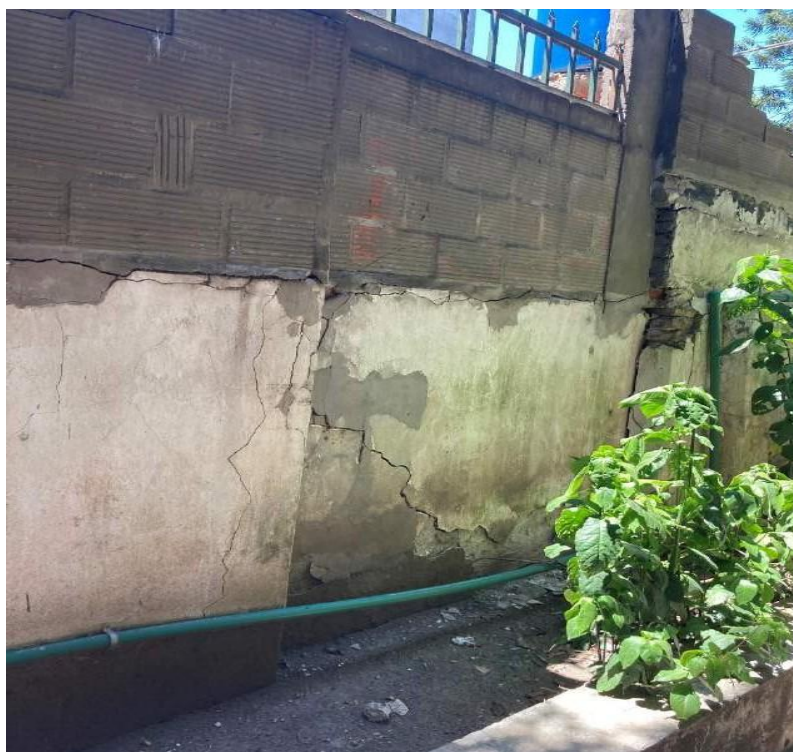
Fotos 28, 29 y 30: Observación 17: Muro medianero con riesgo de caída
