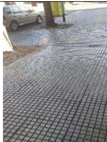
FOTO N° 35: Vereda en buen estado
