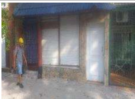
FOTO N° 47: Frente viviendas con escalón y dos columnas fuera del ejido municipal
