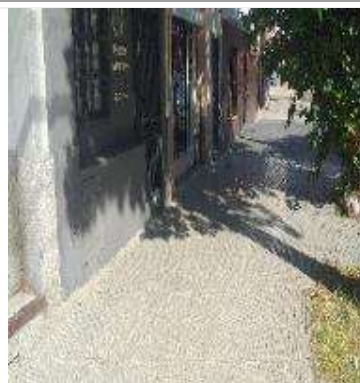
FOTO N° 42: Frente vereda nueva
