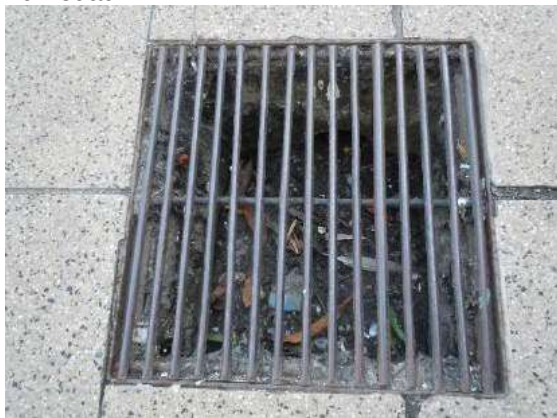
Rejilla/embudo pluvial patio, tapado con tierra/basuras. Sin mantenimiento.
