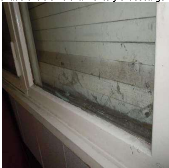
Cortina de enrollar/aberturas. Falta de mantenimiento: Limpieza/engrase.
