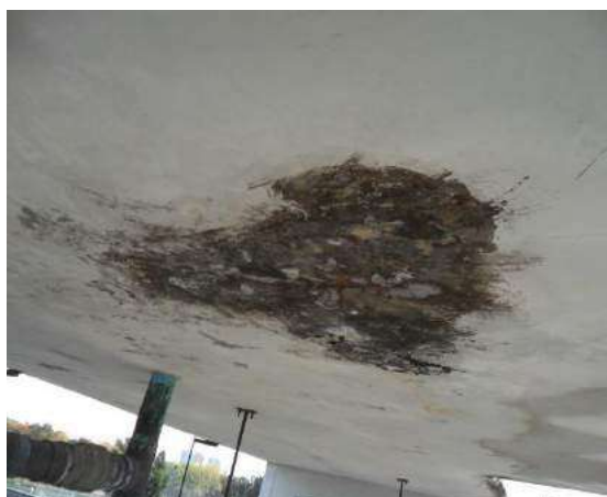
Tanque de agua afectado.
