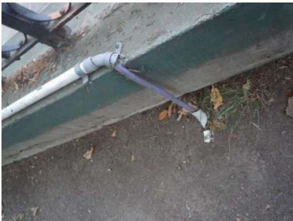
Cableado externo cañería plástica rota
