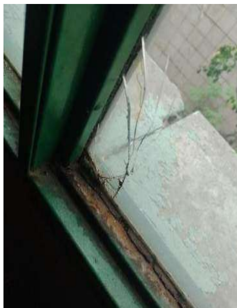
Ausencia de mantenimiento en aberturas. Herrajes sueltos – Vidrio roto. Marco oxidado
