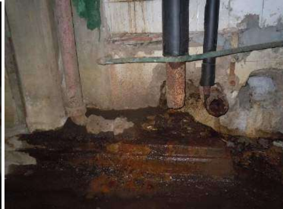
Aislación nueva sobre cañería colapsada.
