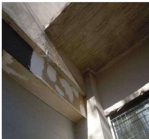
Patio sin terminar/cajas cielorrasos/pintura.
