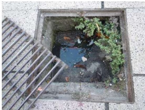
Rejilla/embudo pluvial patio, tapado con tierra/basuras. Sin mantenimiento.
