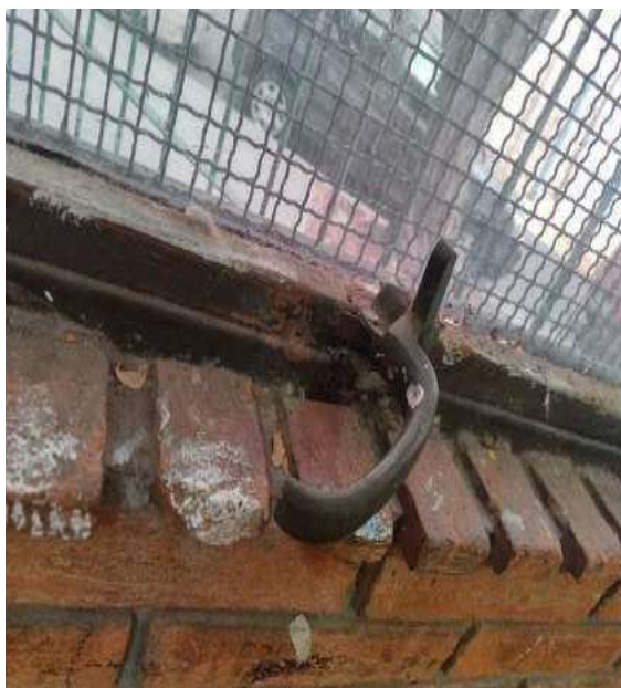
Ausencia de mantenimiento en aberturas. Herrajes sueltos – Vidrio roto. Marco oxidado
