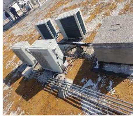
Equipos AA sobre cubierta sin base, cables sin protección.
