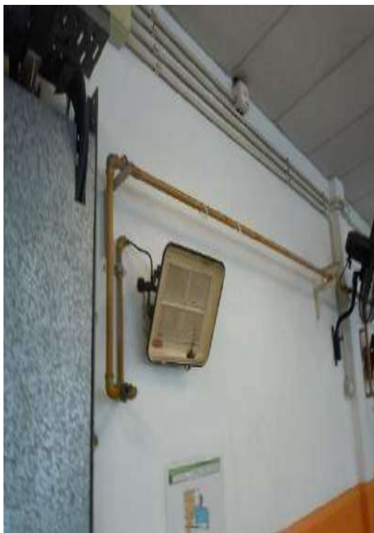
Estufa. Falta volante en llave de paso.
