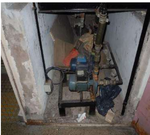
Incorporación de tanque de bombeo, en sala de máquinas agregada, en ojo de la escalera.
