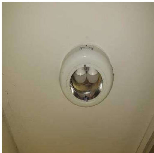
Lámparas inadecuadas. Falta cristal
