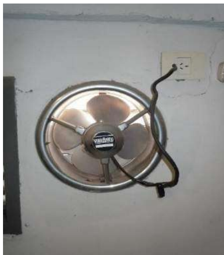
Extractor sala de máquinas. Conexión directa.
