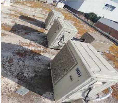
Equipos AA sobre cubierta sin base, cables sin protección.
