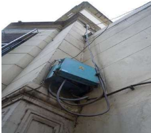
Caja externa de electricidad abierta
