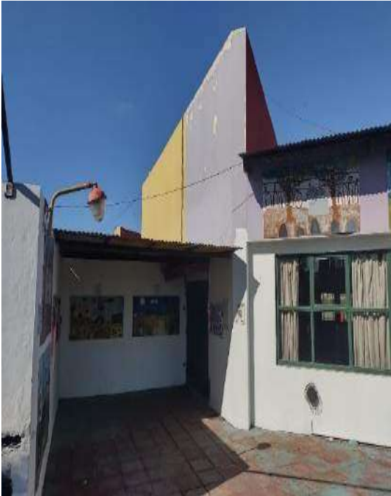
Agregados y cerramiento de mampostería y chapas sobre construcción original
