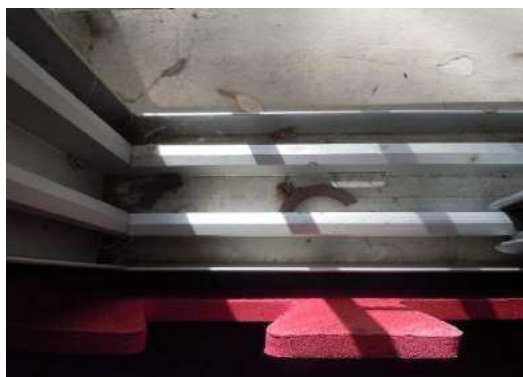
Realizar limpieza de canales de corredizas según Pliegos.
