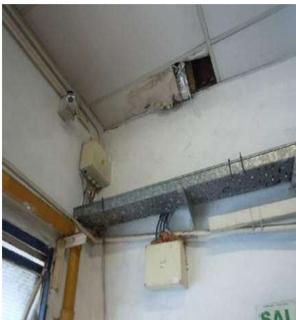
Filtraciones sobre bandeja portacables. Riesgo eléctrico.
