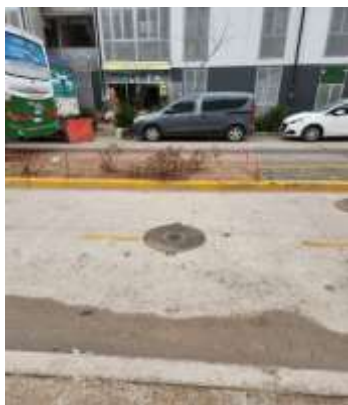
BOCAS DE REGISTRO
