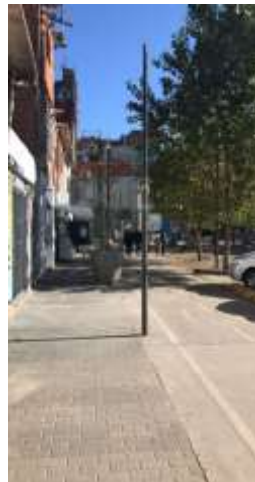
COLUMNAS DE ILUMINACION PAVIMENTO INTERTRABADO Y DE HORMIGON
