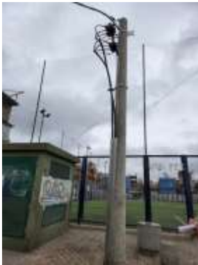
PROVISION DE CABLES PAVIMENTO INTERTRABADO
