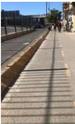
BICISENDA – DEMARCAACION PAVIMENTO DE HORMIGON
