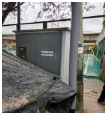
CAMARA DE BOMBEO
