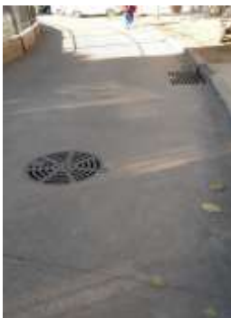
BOCAS DE REGISTRO
