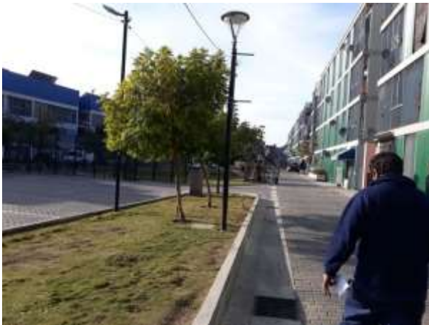
COLUMNAS DE ILUMINACION – SUMIDEROS CANTEROS – PAVIMENTO ARTICULADO
