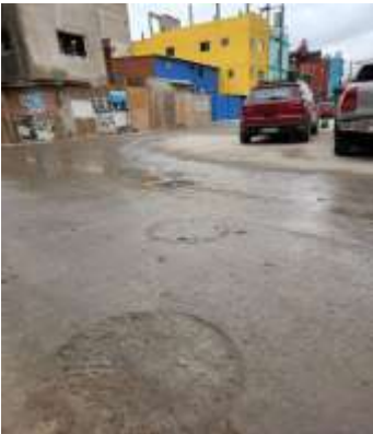
PAVIMENTO DE HORMIGON
