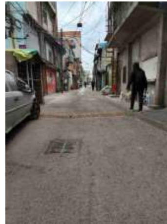
REDUCTOR DE VELOCIDAD SUMIDERO
