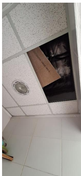
Cielorraso de cocina
