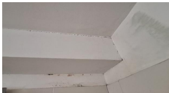
Filtraciones de humedad en baño y cocina
