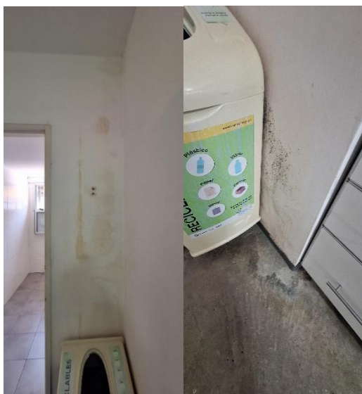
Filtraciones de humedad en baño y cocina
