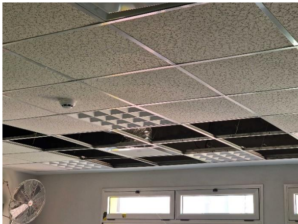
Vista de la sala de 5 años ( 1° piso) con placas de cielorraso suspendido desmontadas por filtraciones de la terraza. Vista del muro del S. Comedor sin pintar.
