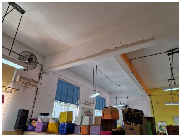
Vista de la sala de 5 años ( 1° piso) con placas de cielorraso suspendido desmontadas por filtraciones de la terraza. Vista del muro del S. Comedor sin pintar.
