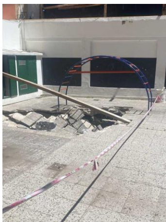
Vista del patio de PB (Edificio histórico) donde se hundi6 el piso. Durante la recorrida por el edificio se detect6 que parte del edificio hist6rico se encontraba clausurado por la DG Guardia de Auxilio y Emergencias (con fecha 27-09-2023)
