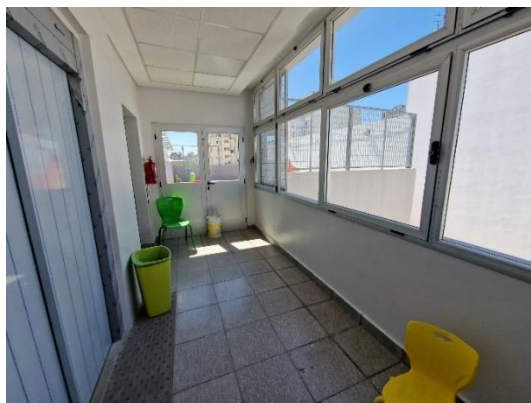
Vista de las aberturas del edificio, las cuales resultan inadecuadas tanto por sus dimensiones como por su sistema de apertura oscilobatiente.
