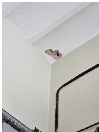
Vista de la bovedilla (sala de nivel inicial) desprendida y pieza de Zócalo de material simil piedra rota (l patio secundario).
