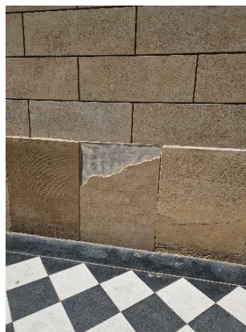
Vista de la bovedilla (sala de nivel inicial) desprendida y pieza de Zócalo de material simil piedra rota (l patio secundario).
