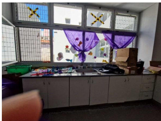
Vista de las aberturas del edificio, las cuales resultan inadecuadas tanto por sus dimensiones como por su sistema de apertura oscilobatiente.
