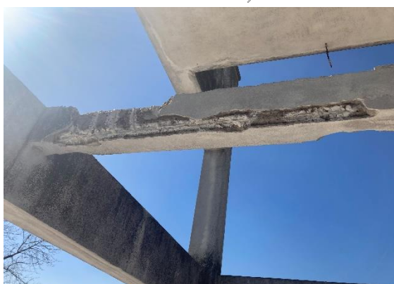
Virgilio: Estructura de tanque
