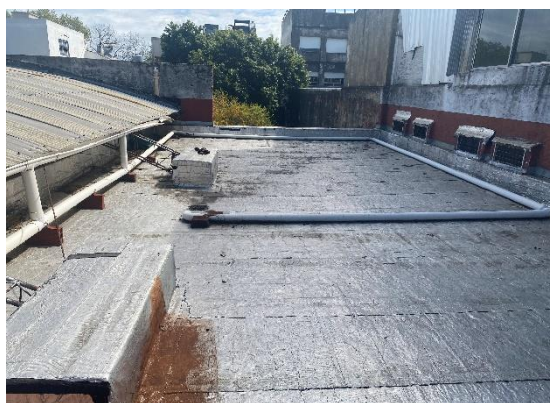
Obra de descarga pluvial inentendible, costosa
