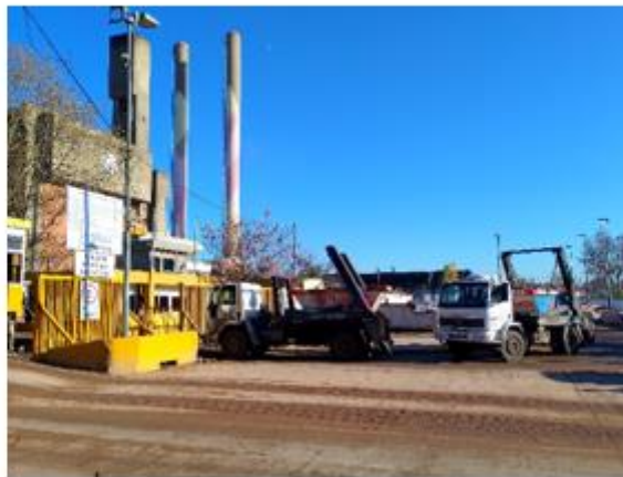
Imagen 3: Puerta de ingreso a la Planta
