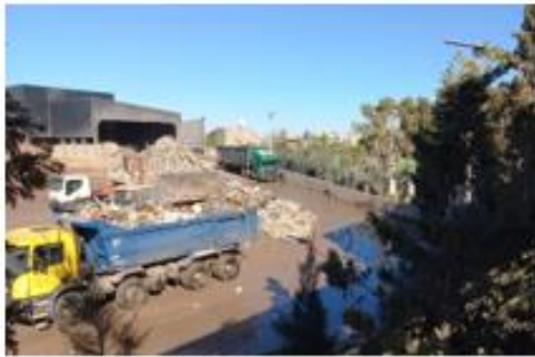
Imagen 30: Zona de acopio y expedición del material procesado y "fracción rechazo"
