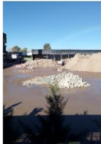
Imagen 29: Zona de acopio y expedición del material procesado
