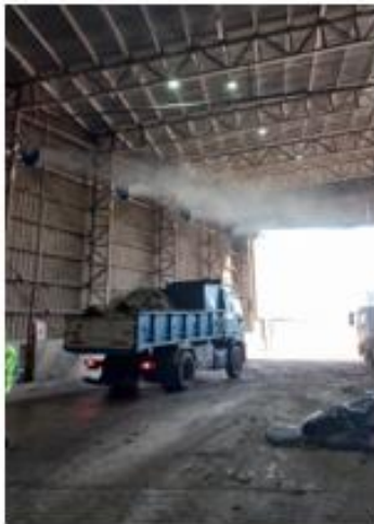
Imagen 12: Cañones pulverizadores de agua
