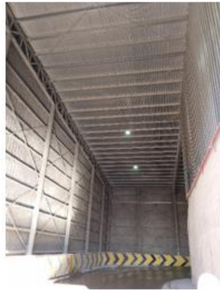
Imagen 11: Entrada a la zona de descarga. Cerramiento metálico
