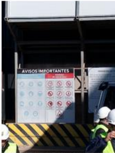
Imagen 34: Señalética de seguridad
