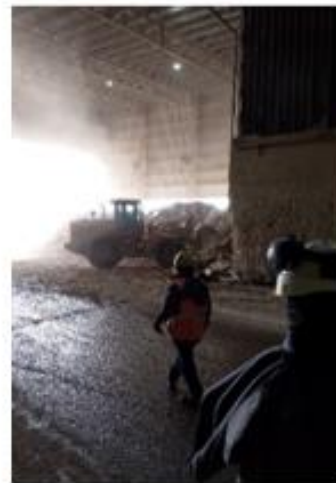
Imagen 13: Retroexcavadora y personal del sector
