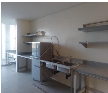
Foto 3 Sector Cocina HO.
