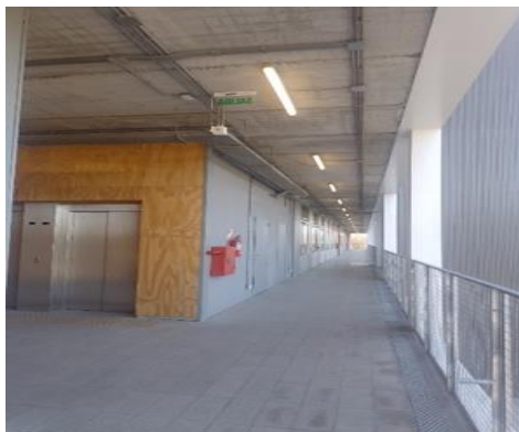
Foto 5 Sector Galerías Lateral HO.
