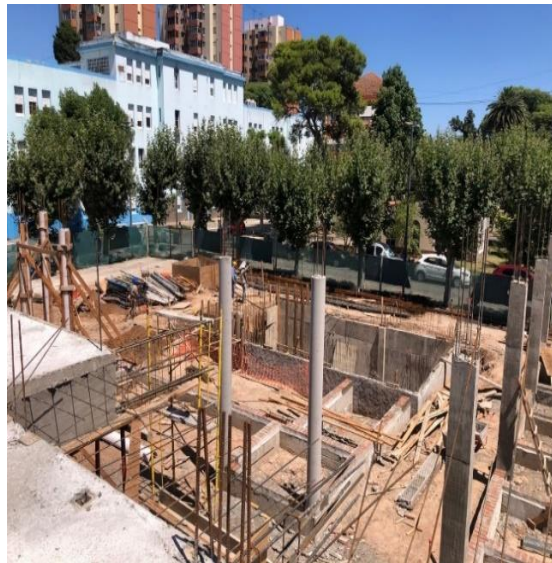
Figura 10 En marcha, armado de encofrados para hormigonar, proceso de construcción de la estructura sobre planta baja.
