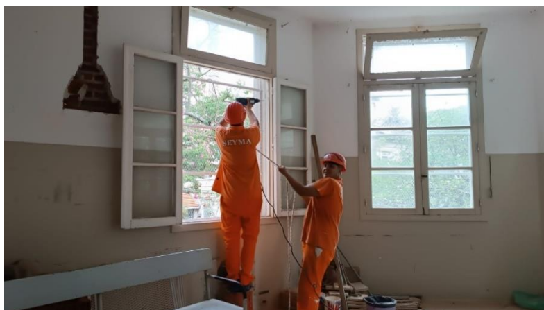
Figura 37 Sala SUM en refacción
