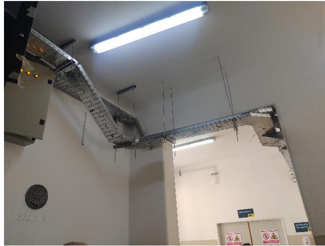
Figura 33 Tendido de cables de alimentación para el área de hemodinamia en bandejas portacables
