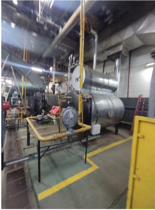
Figura 49 y 50 Reemplazo de Calderas de Calefacción y puesta en norma de instalación de gas, vapor y ACS
