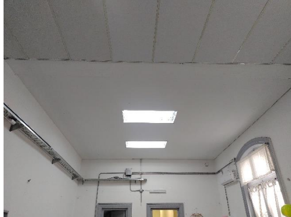
Figura 30 Puerta de Acceso desde Patio del Hospital al Jardín de Infantes Figura 31 Cielorraso nuevo con Iluminación bajo la nueva losa y cielorraso suspendido en placas de roca de yeso reciclado.
