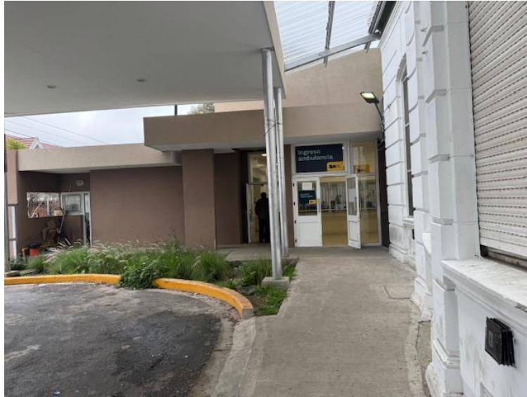
Figura 6 Obra Finalizada Acceso del servicio de urgencias al Pabellón II
