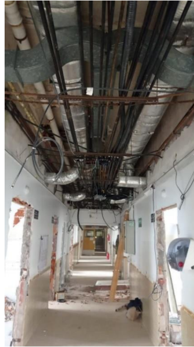
Figura 41 Circulación principal en ejecución con instalación instaladas bajo losa.
