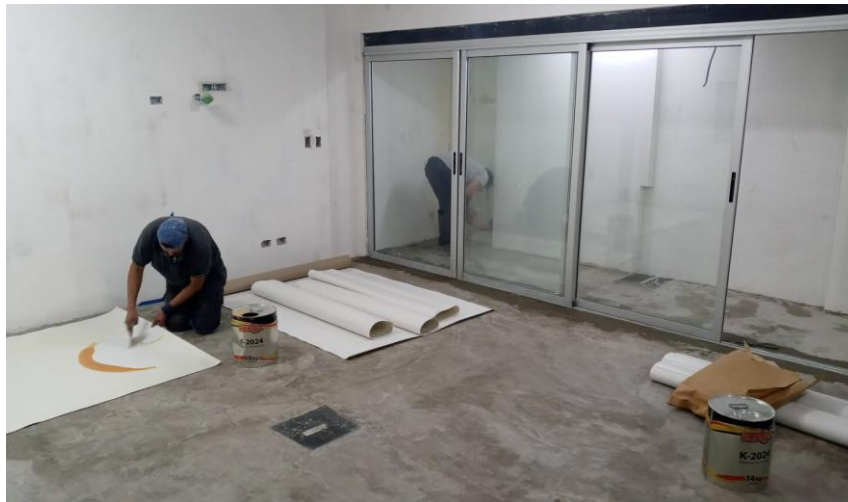
Figura 22 Terminaciones de sala para instalación de equipos
