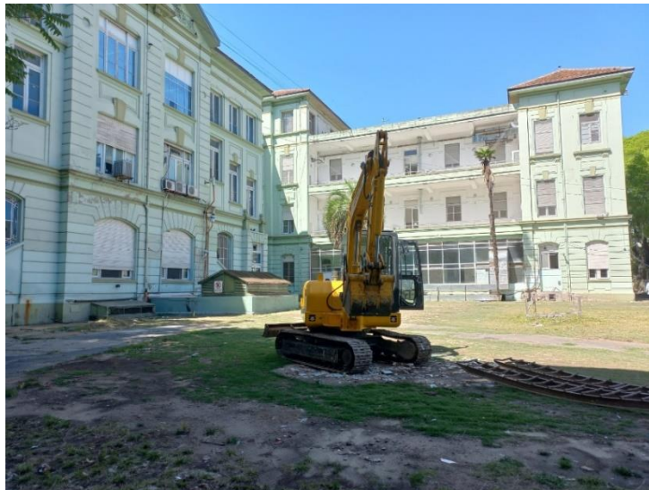
Figura 1 Comienzo de Obra, Movimiento de suelos
