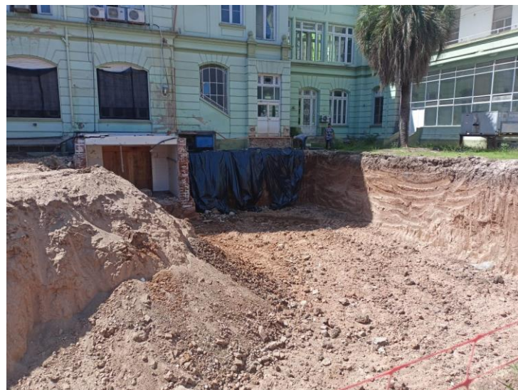
Figura 2 En ejecución de la obra Movimientos de Suelos
