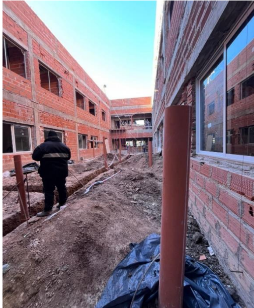
Figura 12 Albañilería y cañeros en ejecución. Figura 13 Revoques Exteriores.
