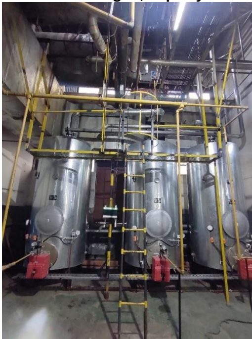
Figura 47 y 48 Reemplazo de Calderas de Calefacción y puesta en norma de instalación de gas, vapor y ACS
