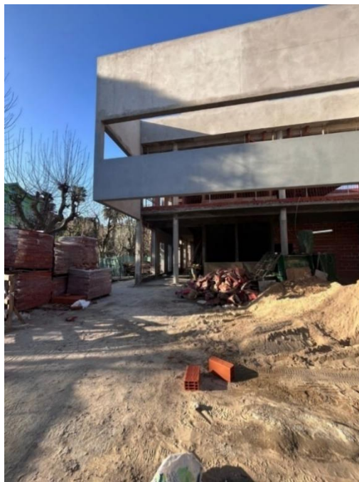
Figura 14 Fachada terminaciones exteriores
