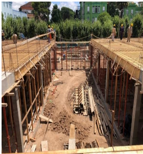
Figura 11 En marcha, armado de encofrados para hormigonar, proceso de construcción de la estructura sobre planta baja
