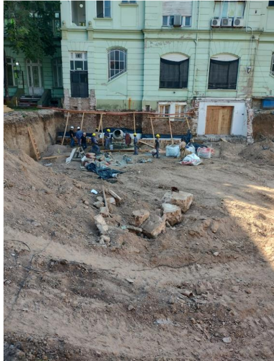
Figura 3 Obra en Pabellón Existente Figura 4 Contención estructural de Pabellón Existente
