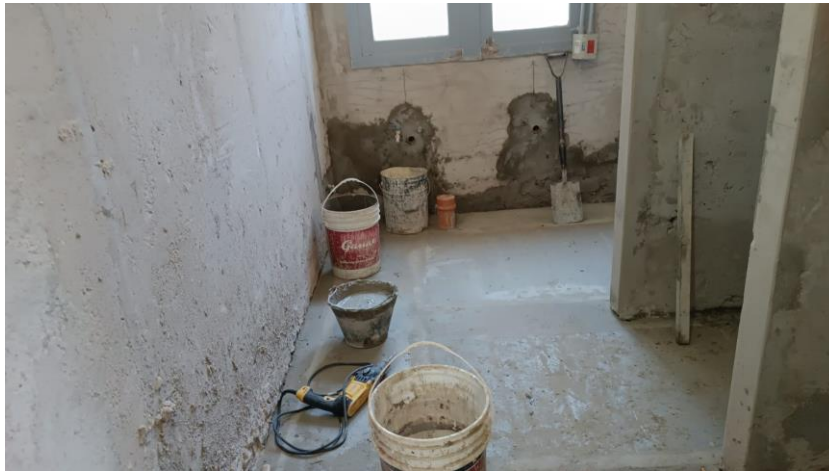
Figura 35 Baños en refacción
