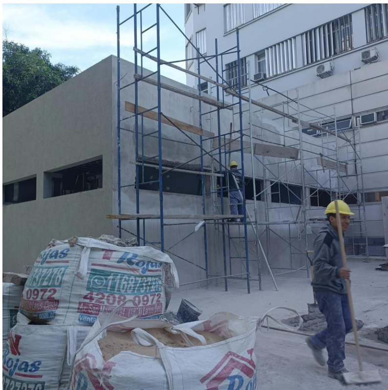
Figura 64 Ampliación en fachada de la Av. Alte Brown para los Nuevos Consultorios Febriles Terminaciones de revoques.
