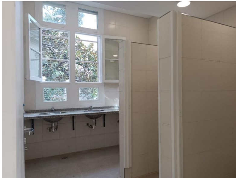
Figura 36 Baños finalizados y con refuerzos en las cañerías de bajo mesada y carpinterías con protección
