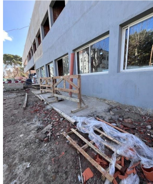
Figura 12 Albañilería y cañeros en ejecución. Figura 13 Revoques Exteriores.
