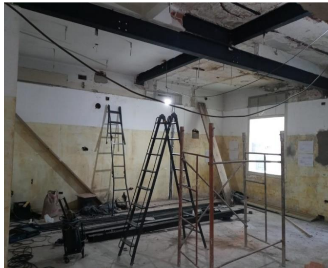
Figura 21 Adecuación Hemodinamia, refuerzos estructurales para instalación de equipos
