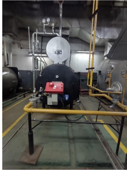
Figura 49 y 50 Reemplazo de Calderas de Calefacción y puesta en norma de instalación de gas, vapor y ACS
