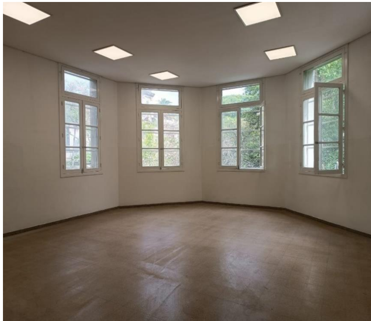
Figura 38 Sala SUM finalizada, nuevo cielorraso, iluminación y protección de seguridad en las carpinterías.
