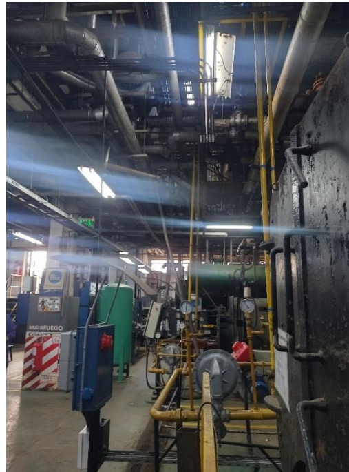
Figura 47 y 48 Reemplazo de Calderas de Calefacción y puesta en norma de instalación de gas, vapor y ACS
