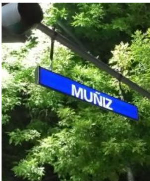
Foto N° 14 PESCANTE EN SEMÁFORO (COLGADO)
