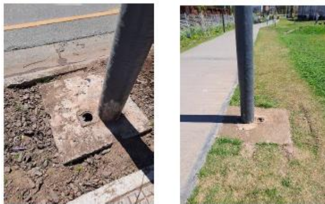
Imagen N°7 Informe de Monitoreo N°3, del 30/10/24 Se observan terrenos nivelados y sin escombros. Se observa puesta a tierra sin tapa de fundición.
