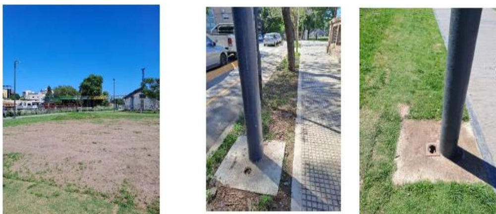
Imagen N°7 Informe de Monitoreo N°3, del 30/10/24 Se observan terrenos nivelados y sin escombros. Se observa puesta a tierra sin tapa de fundición.
