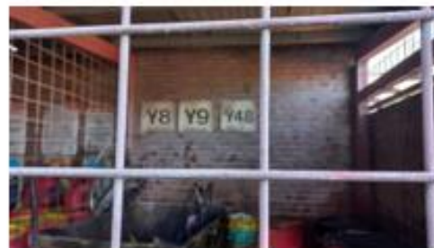
Imagen 37: Depósito transitorio de residuos peligrosos. Identificación de la corriente de residuos peligrosos
