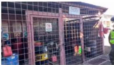
Imagen 36: Depósito transitorio de residuos peligrosos
