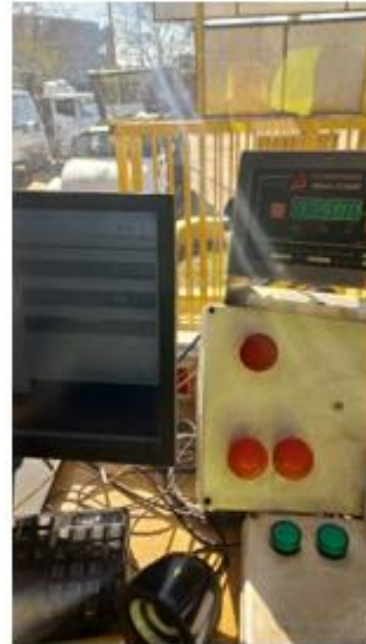
Imagen 5: Cabina de control y pesaje
