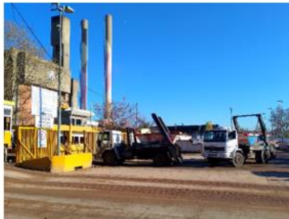
Imagen 3: Puerta de ingreso a la Planta
